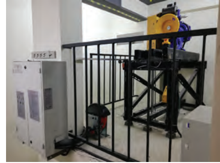
Görsel 11.4: Makine dairesi asansör panosunun yerleşimi
