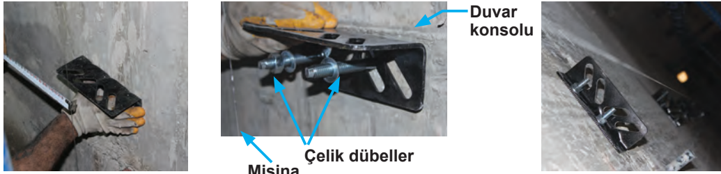
Görsel 5.17: Beton yapıya duvar konsolu bağlantısı
