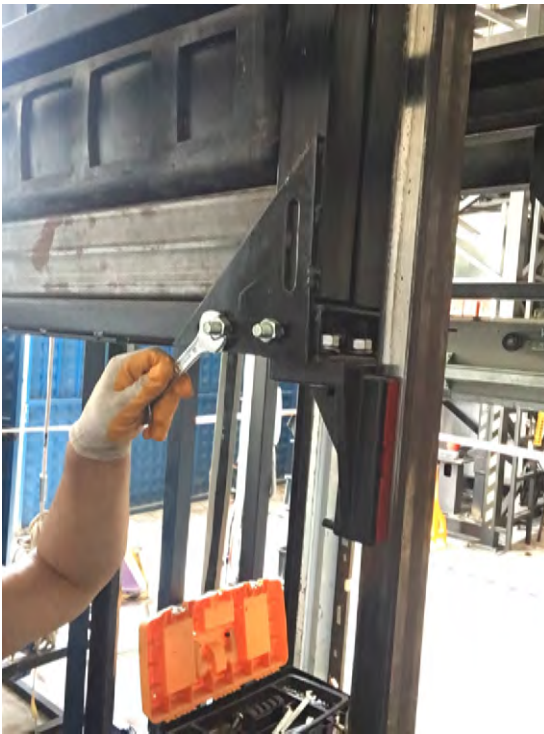
Görsel 8.19: Yan direklerin montajı
