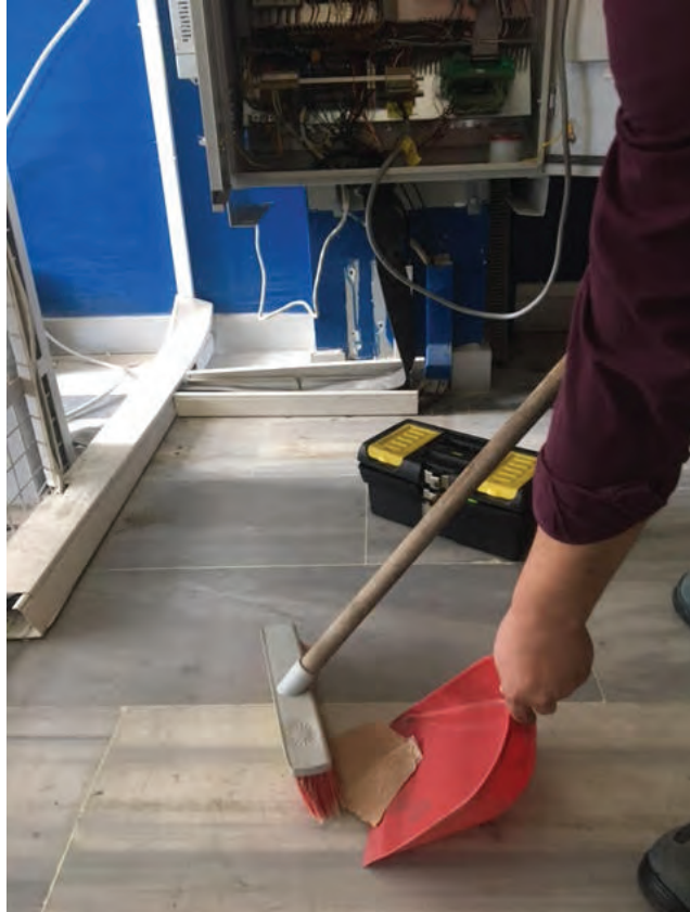
Görsel 12.1: Makine dairesinin zemin temizliği
