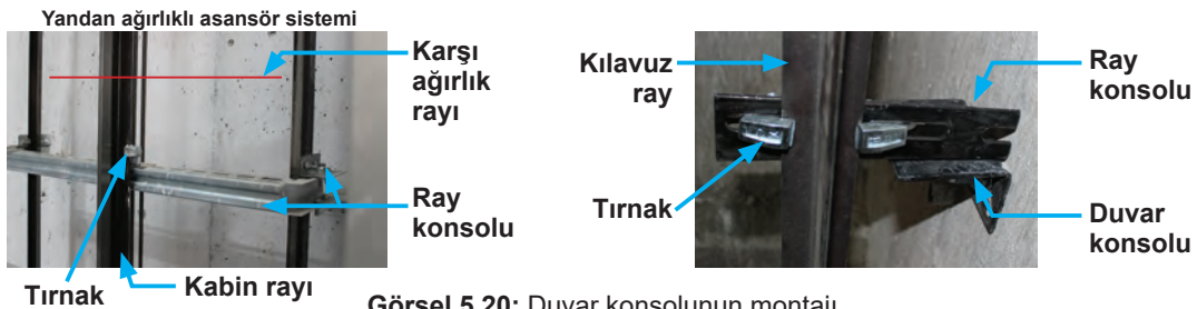
Görsel 5.20: Duvar konsolunun montajı
