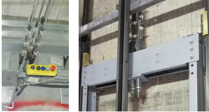
Görsel 8.22: Makine dairesel asansörün halat bağlantıları
