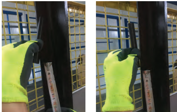
Görsel 12.28: Kat seviyesinin mıknatıslarla ayarlanması
