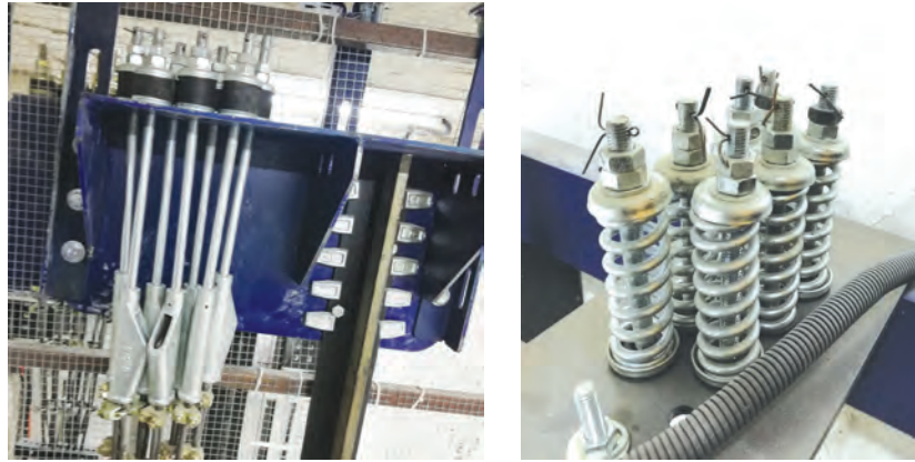
Görsel 8.23: Makine dairesiz asansörün halat bağlantıları
