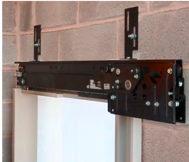
Görsel 6.30: Otomatik kat kapısı mekanizmasının kasaya montajı
