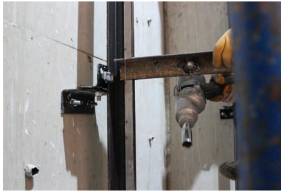
Görsel 5.38: Ray konsolunun montajı
