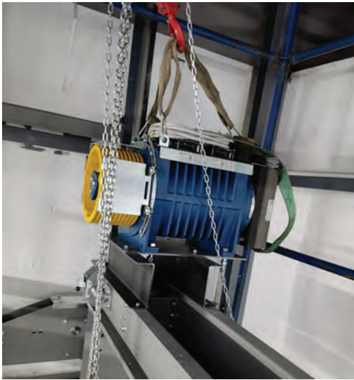
Görsel 7.9: Farklı makine-motor şasesi bağlantıları
