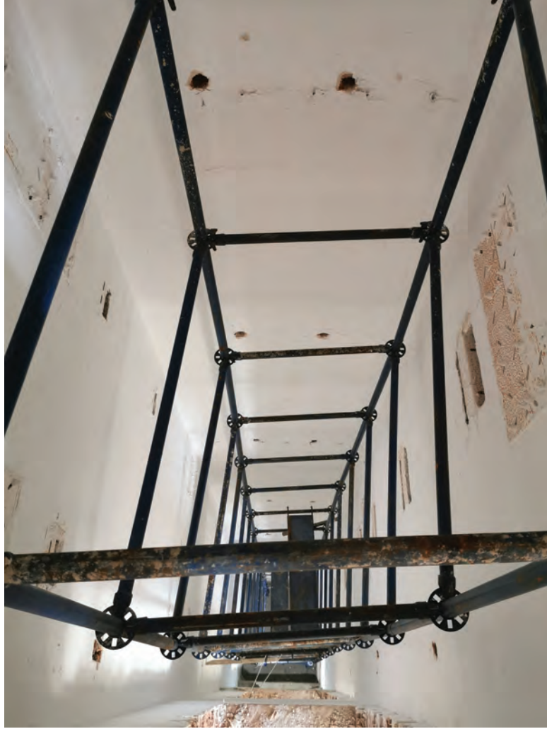
Görsel 4.16: Kuyu içine iskele kurulumu
