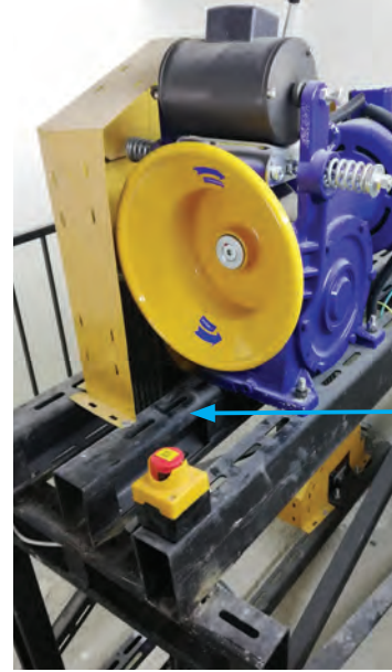
Görsel 11.41: Makine dairesi acil durdurma butonu
