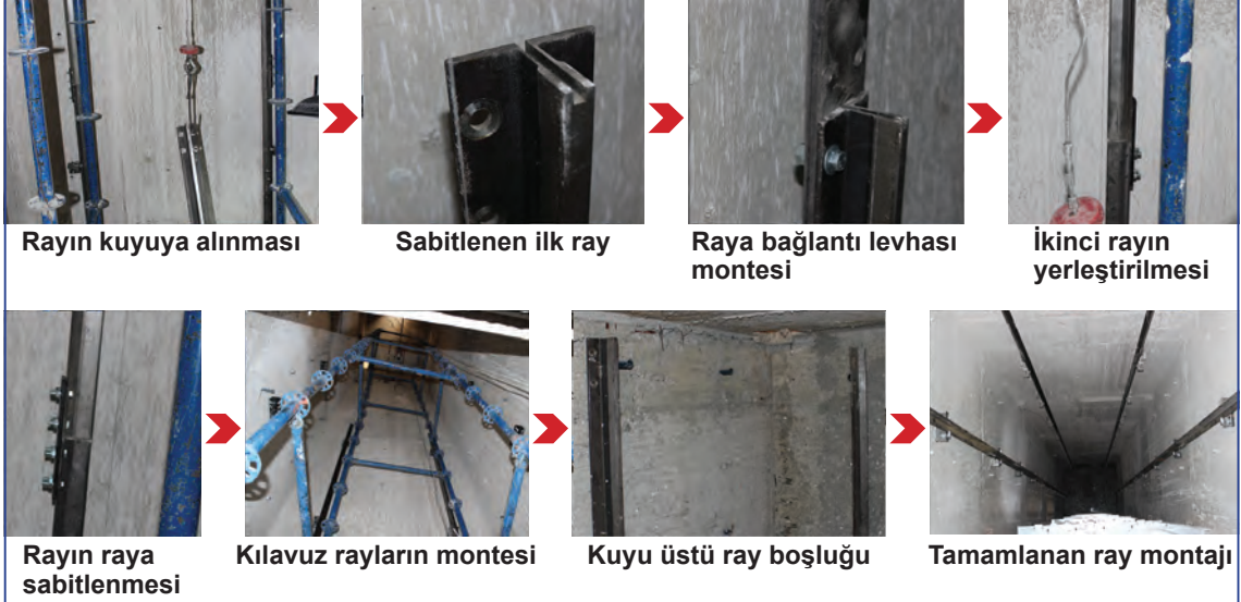
Görsel 5.42: Kabinin ve karşı ağırlık rayının montaj aşamaları
