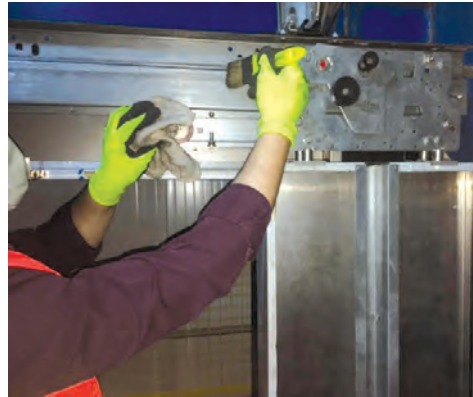
Görsel 12.8: Kat kapısı mekanizmasının temizliği
