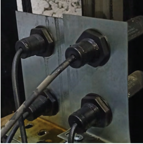
Görsel 11.67: Tüp manyetik şalterlerin montajı
