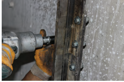
Görsel 5.39: Rayların bağlantı levhasına montajı
