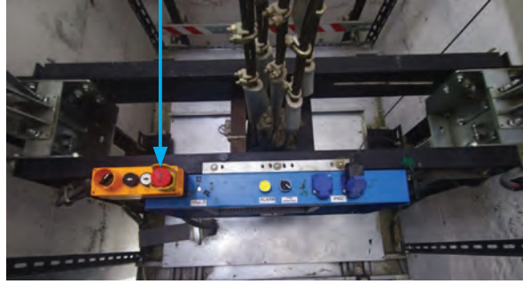
Görsel 11.50: Kabin üstü acil durdurma butonu
