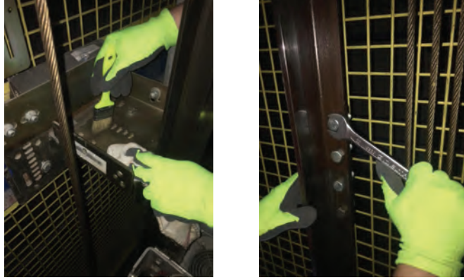
Görsel 12.6: Konsol temizliği ve flanşın mekanik kontrolü
