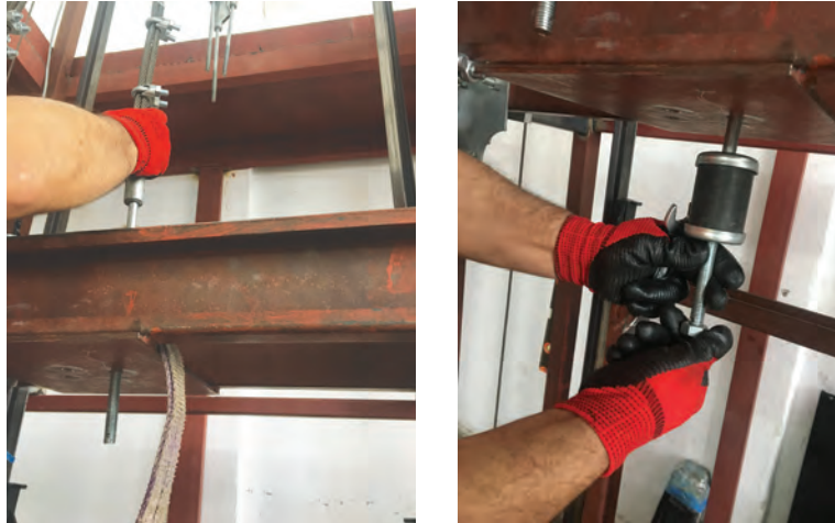
Görsel 8.26: Şişelerin süspansiyona geçirilmesi, kauçuk takozların montajı ve somun takılması
