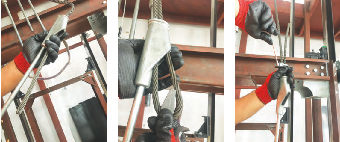
Görsel 8.25: Halatın şişeye geçirilmesi, kamanın takılması ve klemens bağlantısı
