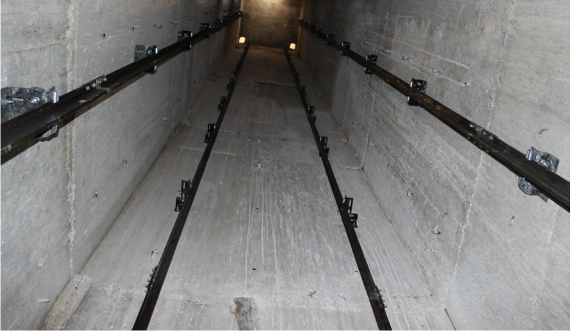
Görsel 5.41: Karşı ağırlık asansör sisteminin kılavuz rayları
