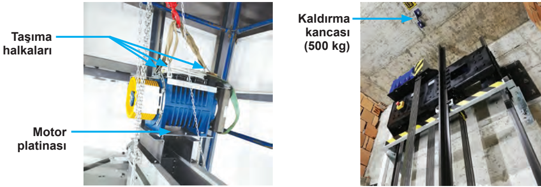
Görsel 7.21: Makine-motor grubu montajı
