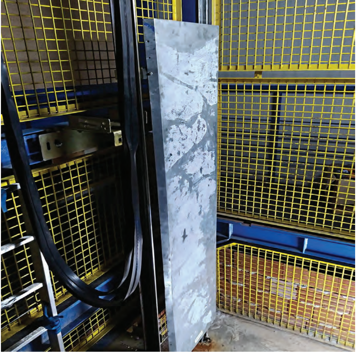
Görsel 10.10: Karşı ağırlık seperatörünün monte edilmiş hâli
