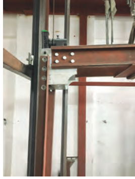
Görsel 8.13: Kabin taşıyıcı iskeletinin montajı
