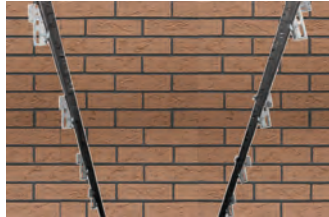
Görsel 5.18: Tuğla yapıya konsol bağlantısı
