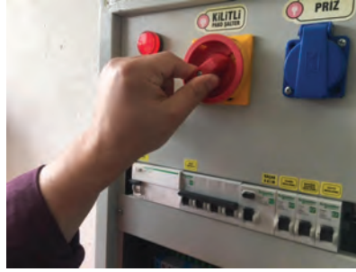
Görsel 12.19: Montaj sonu temizliği ve sisteme enerji verilmesi
