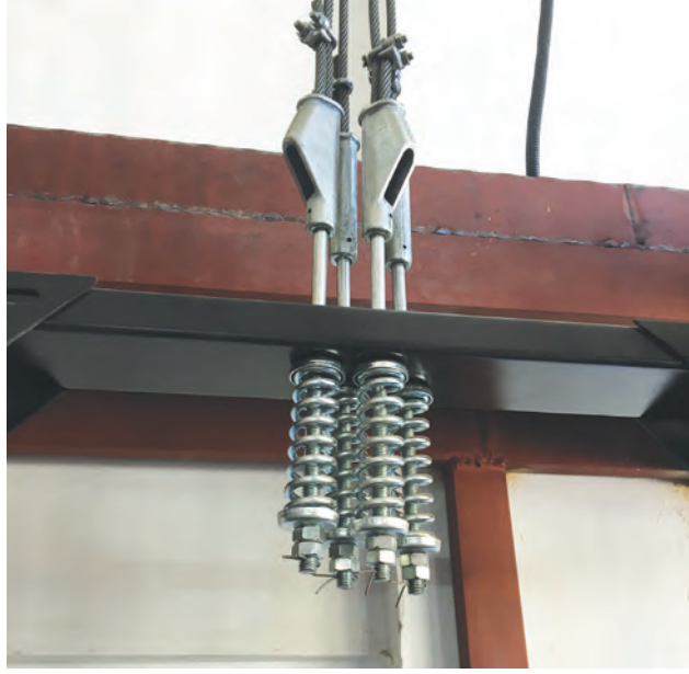
Görsel 8.27: Karşı ağırlık süspansiyonunun halat ve şişe bağlantısı
