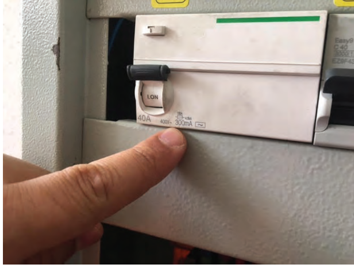
Görsel 12.16: Ürünün etiket değerinin kontrolü
