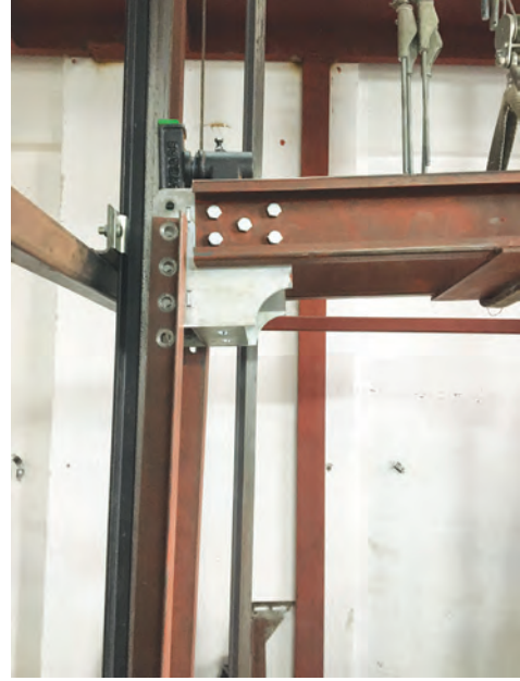
Görsel 8.11: Yan direklerin montajı
