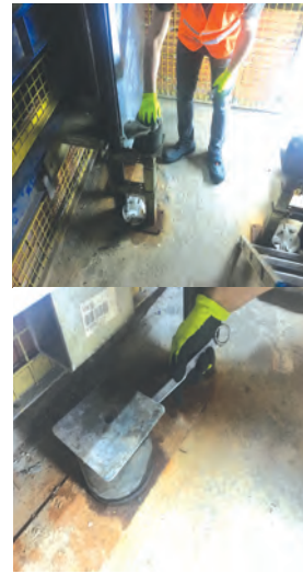
Görsel 12.12: Kabinin ve karşı ağırlık tamponunun kontrolü
