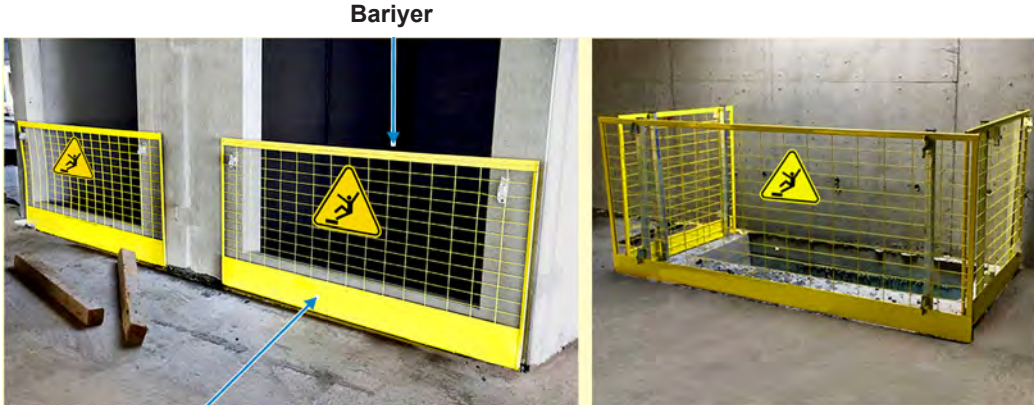
Görsel 1.12: Asansör boşluk girişlerindeki bariyerler
