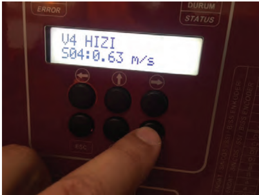
Görsel 12.26: İnvertörün ayarlanması
