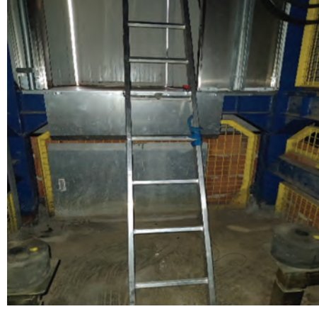
Görsel 10.13: Kuyu dibi merdivenin askıdan çıkarılıp kat kapısından kuyu dibine doğru uzanmış şekli
