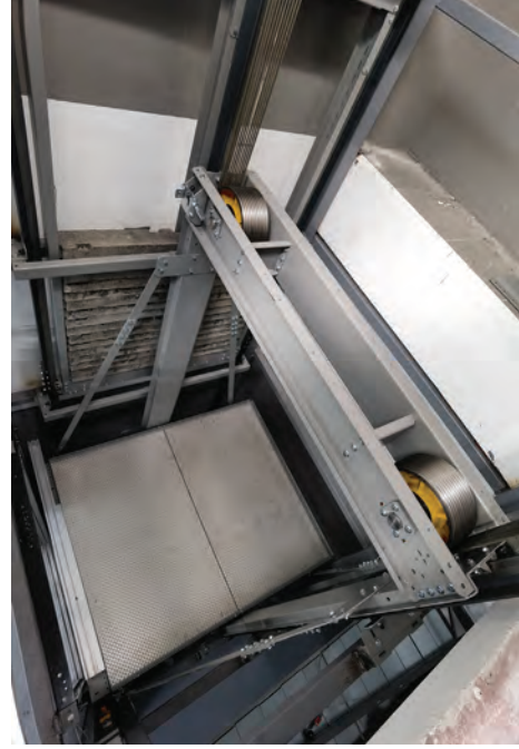
Görsel 7.8: Motora gelen yükü azaltan kasnak sistemleri
