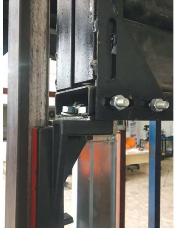
Görsel 8.18: Karşı ağırlığın paten montajı
