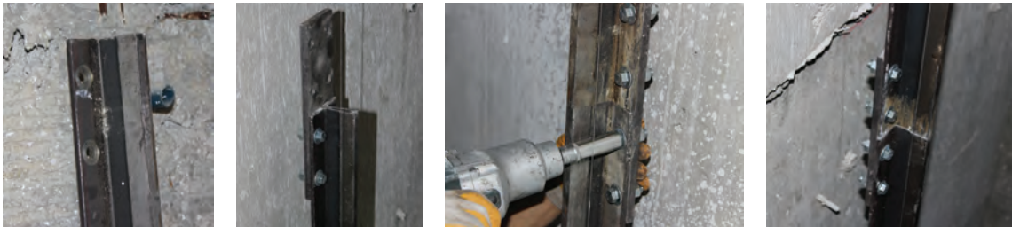
Görsel 5.28: Bağlantı levhasının montajı
