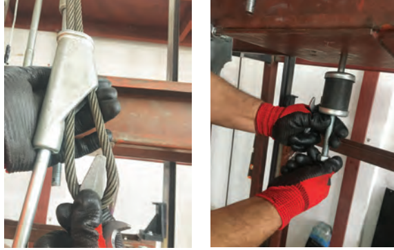
Görsel 8.28: Halatın şişelere montajı
