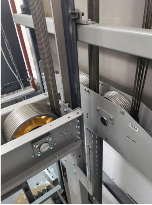
Görsel 7.8: Motora gelen yükü azaltan kasnak sistemleri
