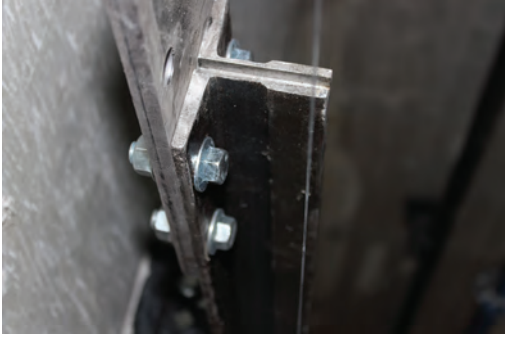
Görsel 5.39: Rayların bağlantı levhasına montajı
