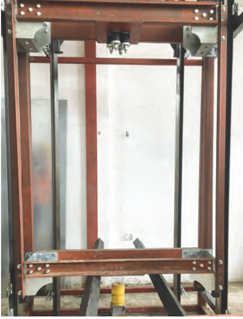
Görsel 8.10: Üst süspansiyonun askıya alınması
