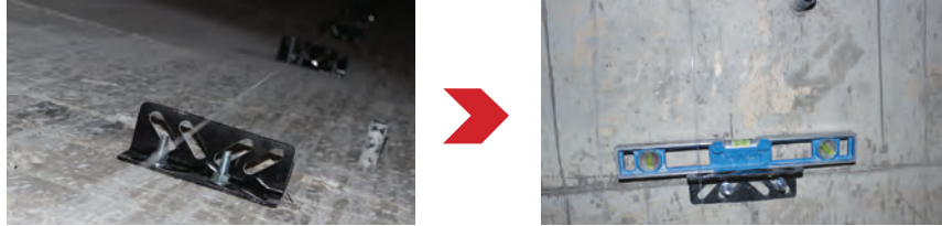
Görsel 5.19: Duvar konsolunun montajı
