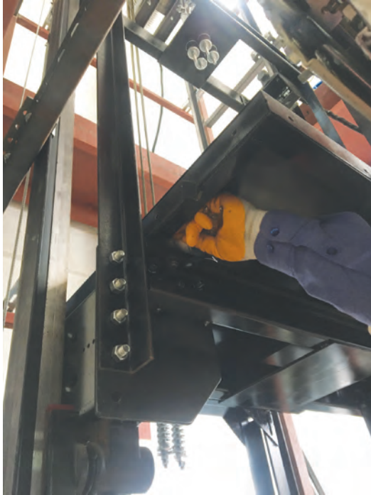
Görsel 8.31: Kabin tabanının süspansiyona montajı
