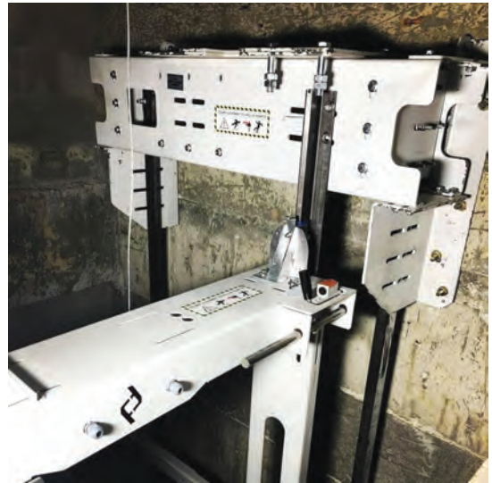
Görsel 7.9: Farklı makine-motor şasesi bağlantıları
