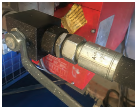
Görsel 2.9: Yağ kaçaklarının kontrolü
