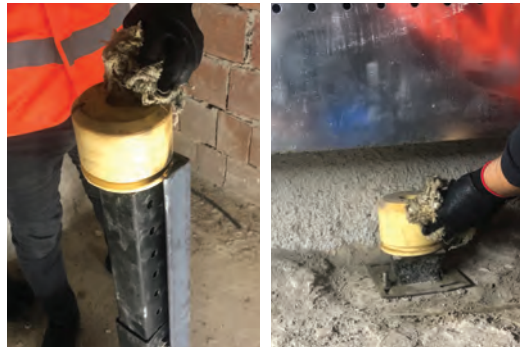
Görsel 2.57: Kuyu dibi tamponlarının kontrolleri
