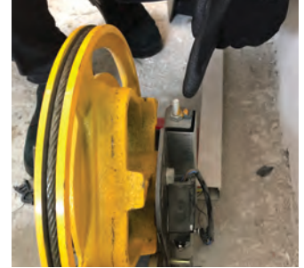
Görsel 2.12: Hız regülatörünün mühür kontrolü
