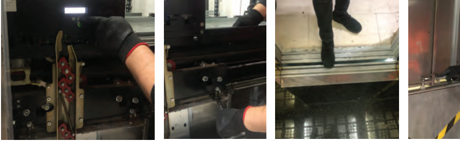
Görsel 2.49: Kat kapılarının bakımı ve onarımı
