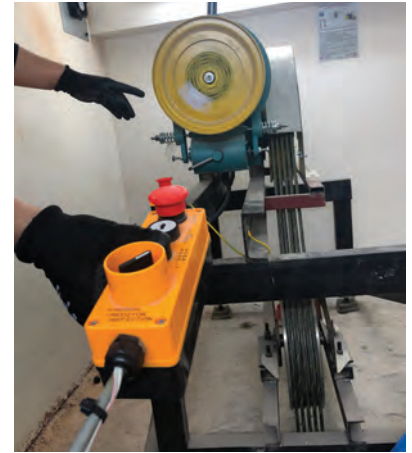
Görsel 2.2: Makine-motor grubunun çalışmasının kontrol edilmesi
