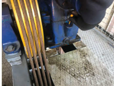
Görsel 2.5: Makinenin (redüktörün) yağ kontrolü
