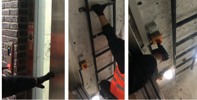
Görsel 2.56: Kuyu dibine güvenli giriş işlemleri
