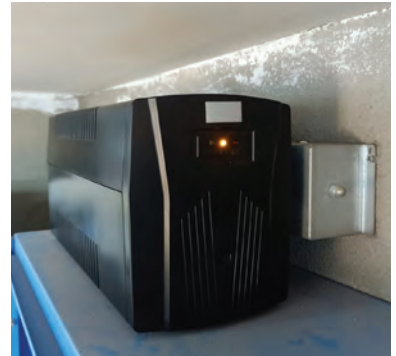
Görsel 2.18: UPS otomatik kurtarma sistemi
