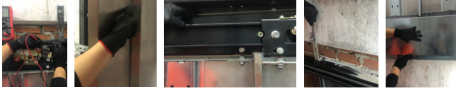
Görsel 2.46: Kat kapılarının bakımı ve onarımı
