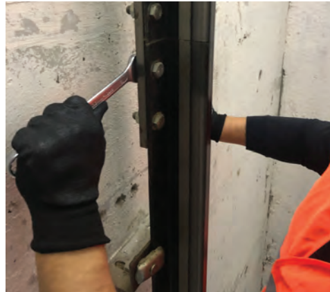
Görsel 2.29: Flanşların kontrolü
