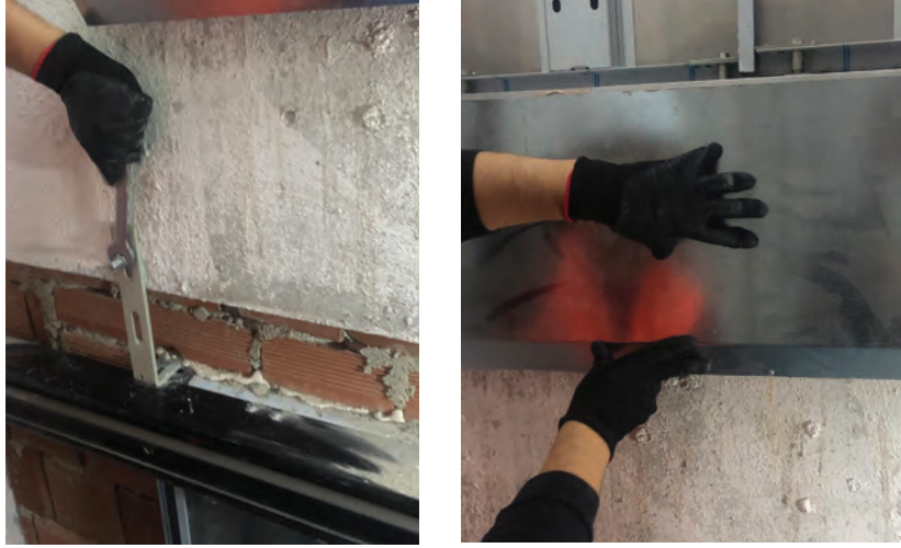
Görsel 2.42: Kapı kasasının ve etek sacının kontrolü
