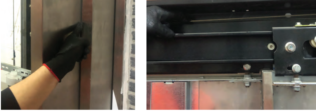
Görsel 2.40: Mekanizmanın ve kapı birleşim yerinin kontrolü
