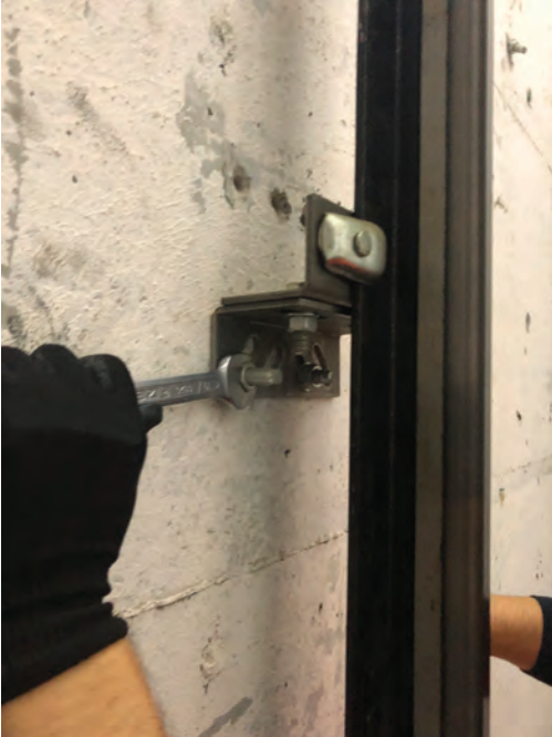
Görsel 2.28: Konsolların ve tırnakların kontrolü
