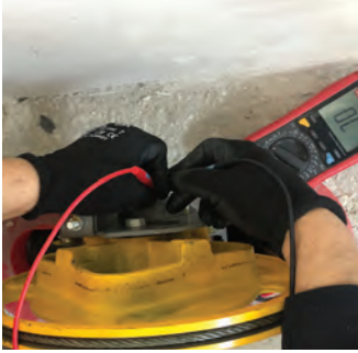
Görsel 2.13: Hız regülatörünün kontak kontrolü
