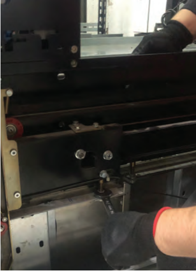
Görsel 2.48: Kabin kapısı panellerinin ve eşiğinin kontrolü
