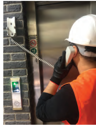
Görsel 2.54: Diyafonun kontrolü
