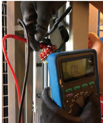
Görsel 2.45: Kapı konağının kontrolü
