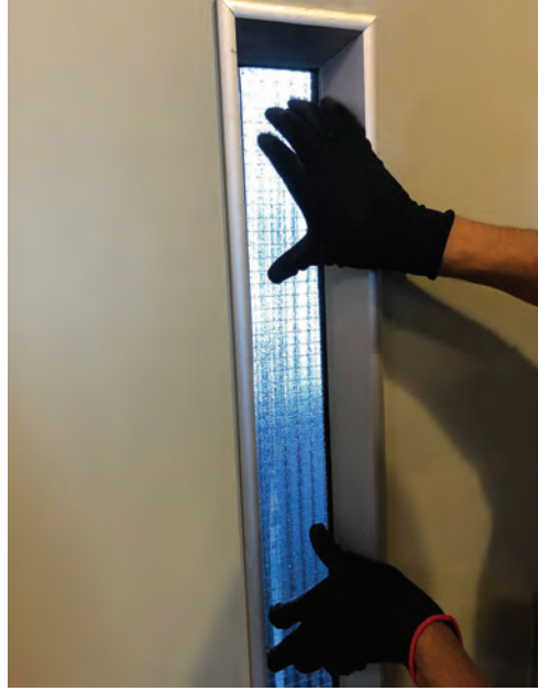
Görsel 2.44: Kapı camının kontrolü
