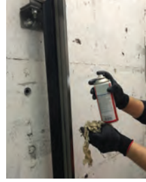
Görsel 2.38: Kabin üstünün bakımı ve onarımı
