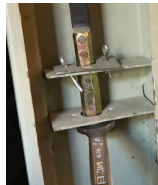
Görsel 2.43: Kapı yayının kontrolü
