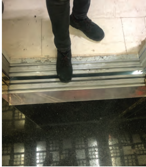
Görsel 2.48: Kabin kapısı panellerinin ve eşiğinin kontrolü
