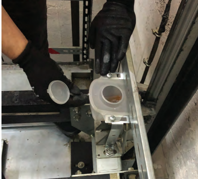
Görsel 2.31: Yağ seviyesinin kontrolü
