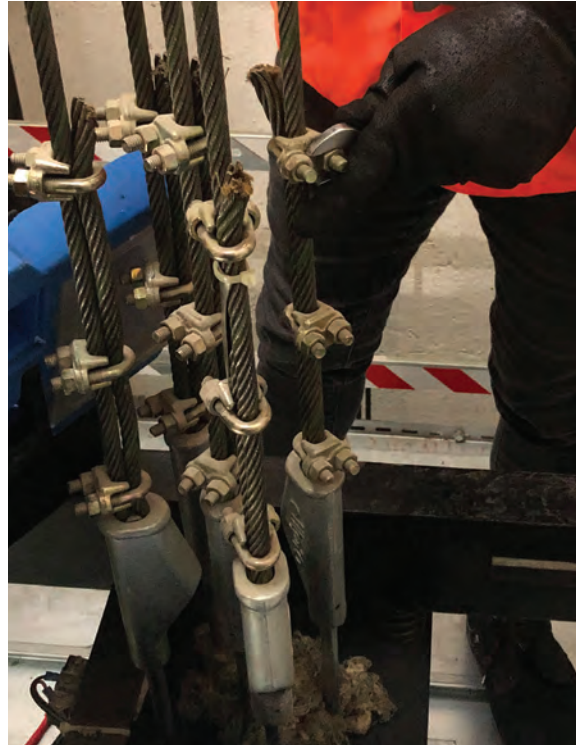
Görsel 2.33: Halat bağlantılarının kontrolü
