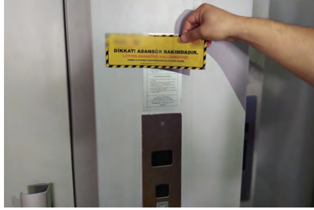
Görsel 3.2: Asansörün bakımda olduğunu gösteren uyarı etiketi
