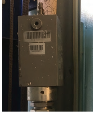
Görsel 2.10: Boru kırılma valfinin kontrolü
