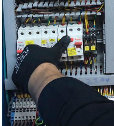
Görsel 2.20: Kaçak akım rölesinin testi
