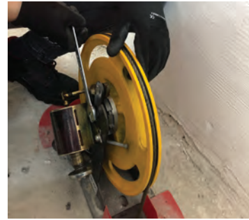
Görsel 2.11: Hız regülatörünün mekanik kontrolü
