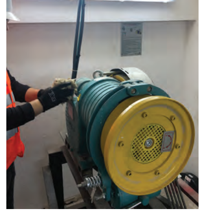
Görsel 2.1: Makine-motor grubunun temizliği
