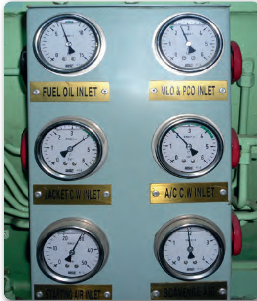
Görsel 7.2: AC jeneratör dizel motor gösterge panosu
