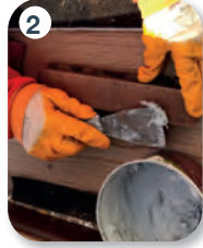
Görsel 5.15: Ahşap yüzeyde raspa boya yapma aşamaları
