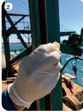
Görsel 5.6: Tel halatı yağlama aşamaları
