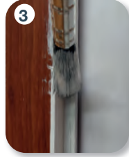
Görsel 5.15: Ahşap yüzeyde raspa boya yapma aşamaları
