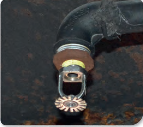
Görsel 3.15: Açık tip sprinkler nozulu
