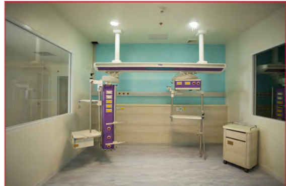
Görsel 1.10: Yapım aşamasında bir izolasyon odası
