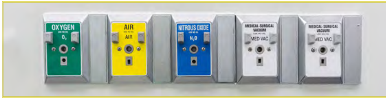
Görsel 4.3: Anestezi cihazı ile merkezî gaz santral sisteminin bağlantı noktası
