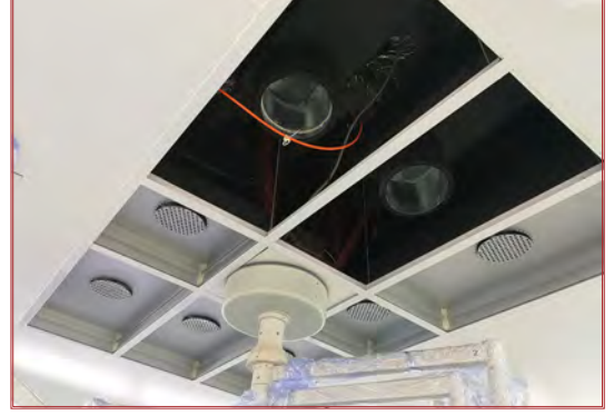
Görsel 1.18: Temiz odada HEPA filtre kurulumundan bir görüntü
