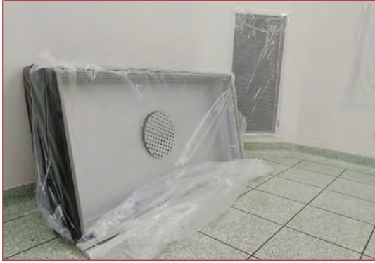
Görsel 1.17: Temiz odada HEPA filtre kurulumundan bir görüntü
