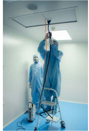
Görsel 2.11.b: Hepa filtre kontrol testi
