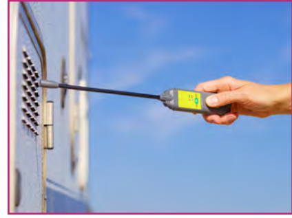
Görsel 8.6: Dedektörle gaz kaçağı tespiti
