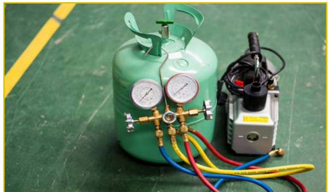
Görsel 6.9: Soğutma sistemine gaz tüpünün bağlanması
