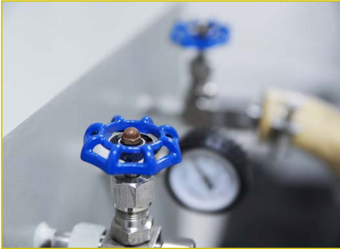
Görsel 6.6: Sabun köpüğü ile gaz kaçağı tespiti
