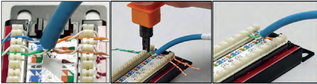
Görsel 7.43: Patch panel üzerinde kablo çakma işlemi
