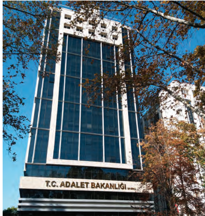
G rsel 1.13: Adalet Bakanlıėı binası
