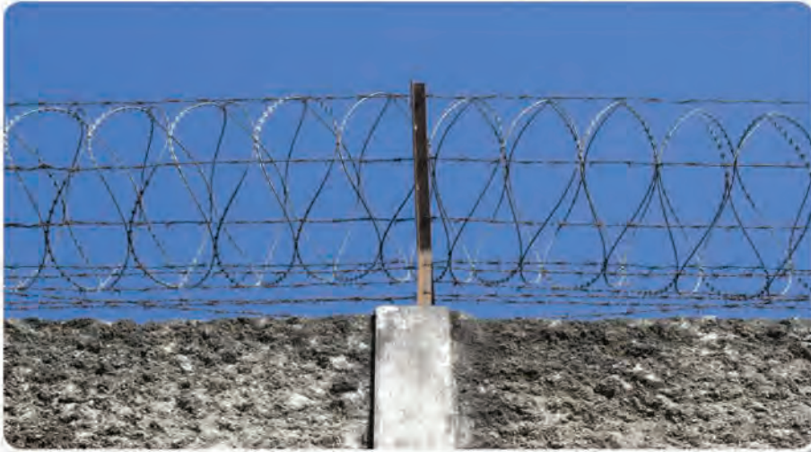
Görsel 4.26: İhata duvarı üzerindeki jiletli teller
