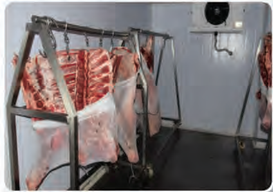
Görsel 3.37: Soğuk hava deposu
