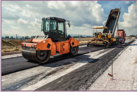
Görsel 1.58: Yol yapım çalışması
