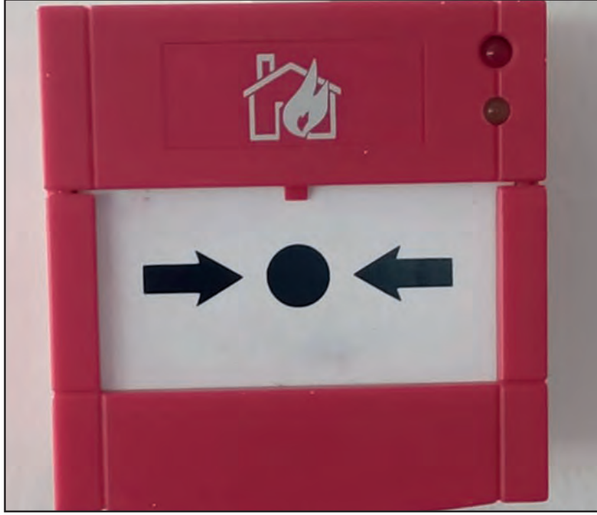
Görsel 1.24: Yangın alarm butonu
