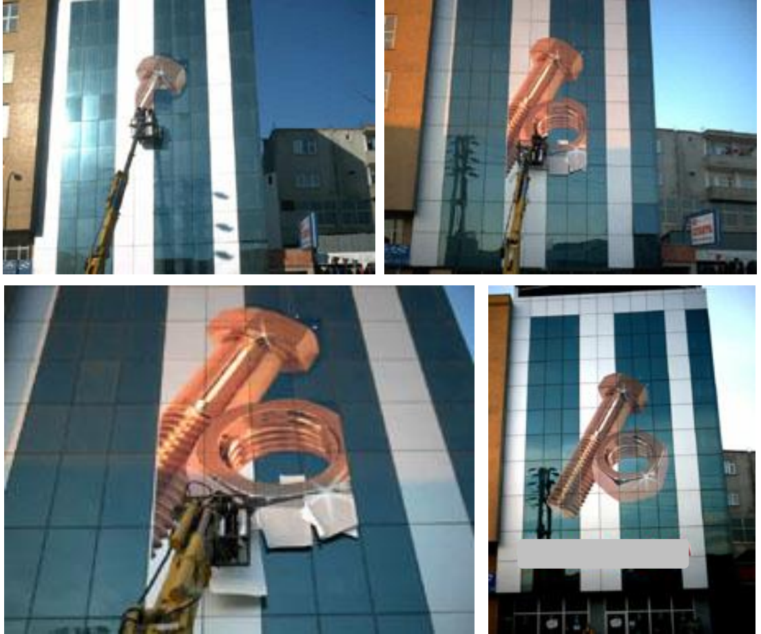
Resim 1.15: Bina giydirmesinin yapılması
